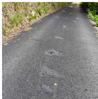
Komunikace jsou opraveny, plevel vytržen. Foto: Kryštof Vyletal (17. 6.)
